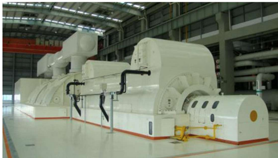
东方电机制造的华能海门电厂1000MW超超临界汽轮发电机在运行中。
