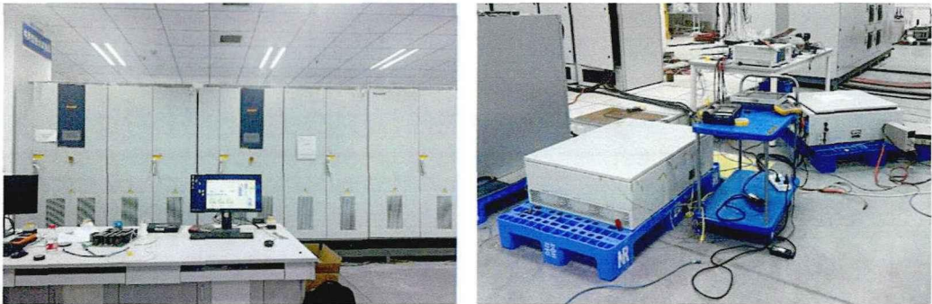
图 4-15 南瑞继保厂内实机测试平台照片
